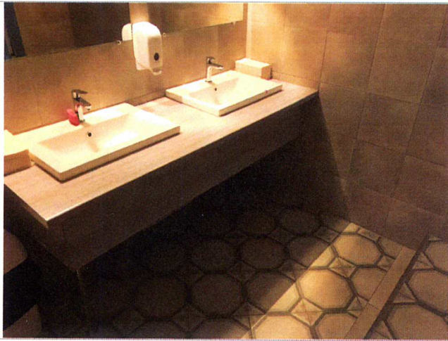
Фото №43 – Санитарно-гигиенические помещения
