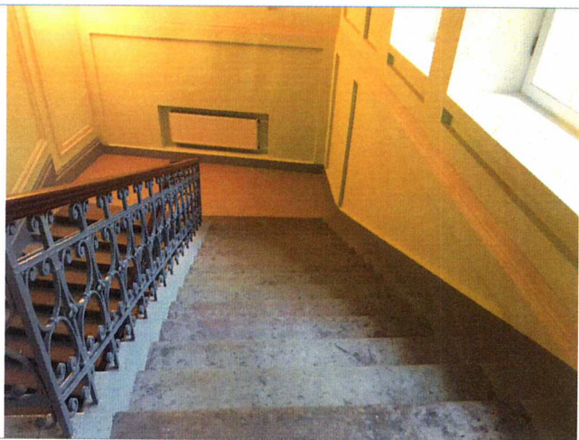
Фото №26 – Пути движения внутри здания (лестницы)
