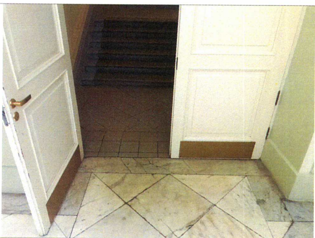
Фото №30 – Пути движения внутри здания (двери)
