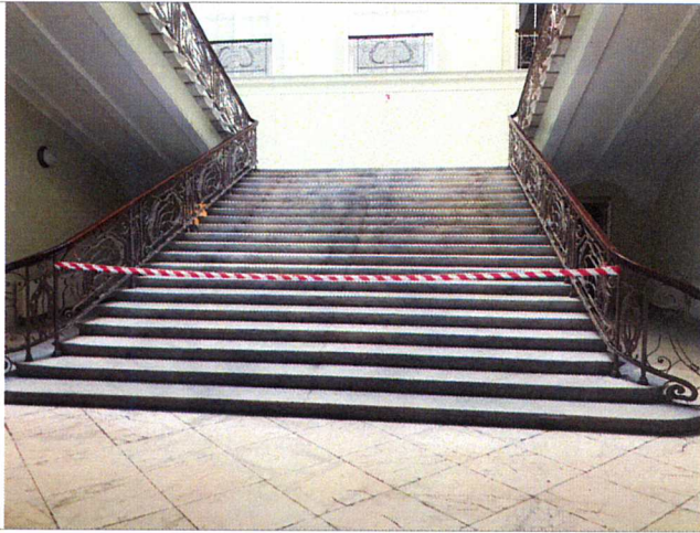
Фото №19 – Пути движения внутри здания (лестницы)
