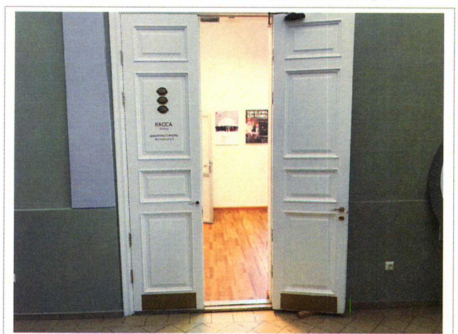
Фото №12 – Пути движения внутри здания (двери). Касса.
