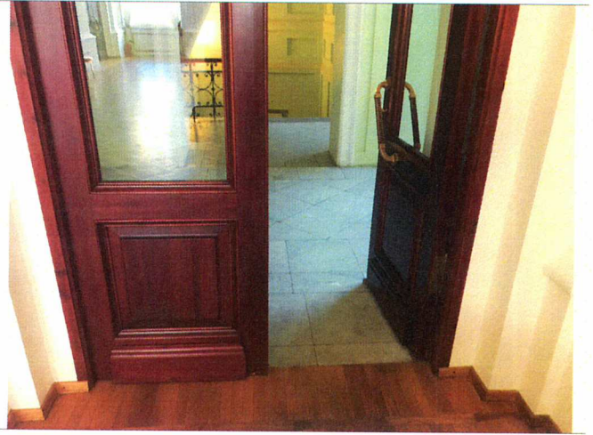
Фото №32 – Пути движения внутри здания (двери)
