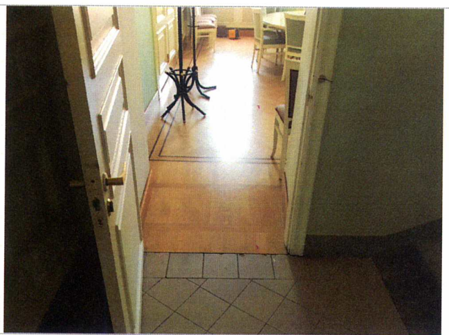
Фото №29 – Пути движения внутри здания (двери)
