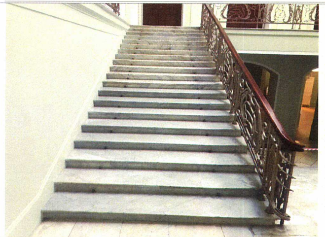
Фото №22 – Пути движения внутри здания (лестницы)
