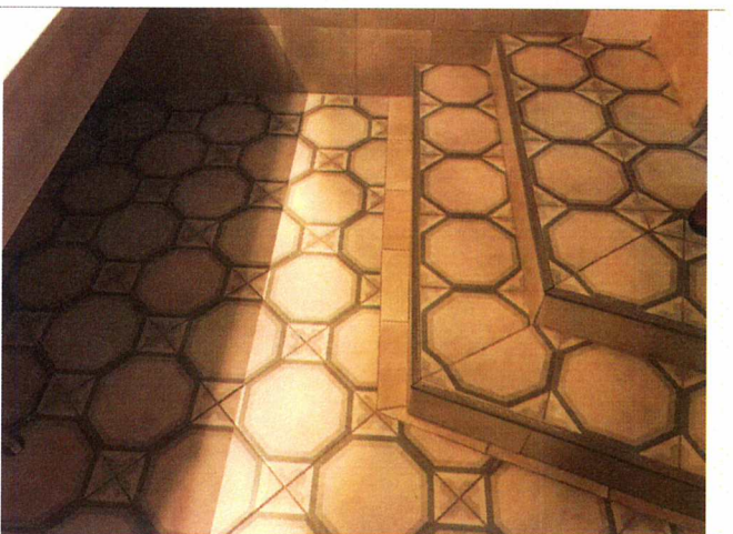
Фото № 42 – Санитарно-гигиенические помещения
