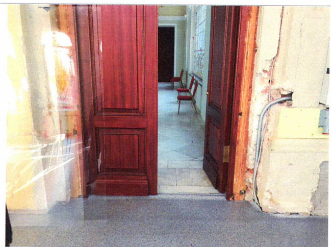
Фото №27 – Пути движения внутри здания (двери)
