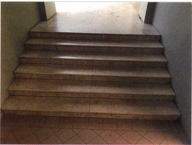
Фото №23 – Пути движения внутри здания (лестницы)
