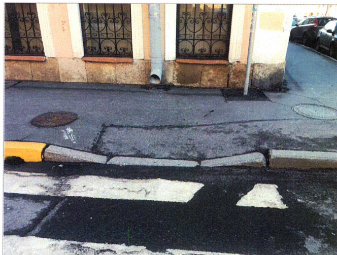
Фото №2 – Подходы к объекту.
