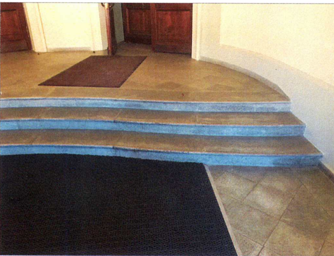
Фото №9 – Пути движения внутри здания (лестницы)
