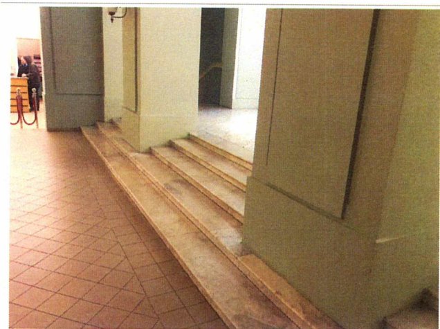
Фото №18 - Пути движения внутри здания (лестницы).
