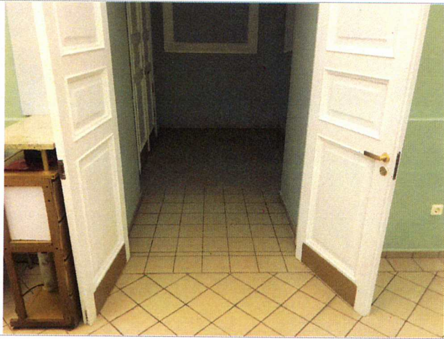
Фото №31 – Пути движения внутри здания (двери)
