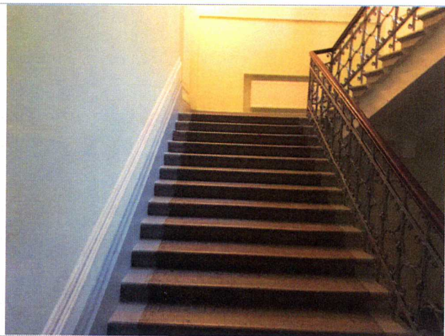
Фото №25 – Пути движения внутри здания (лестницы)
